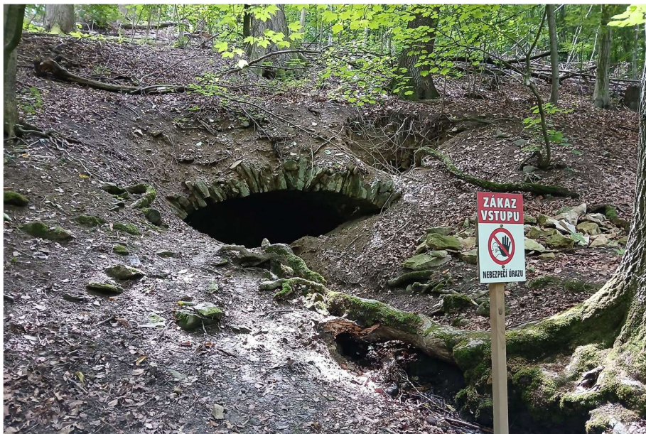
Foto 15: Tzv. Sklepní pramen je jedním z mála pozůstatků parkové úpravy a staveb z 19. století. V současnosti existuje záměr na jeho úpravu. 29. 7. 2025.
