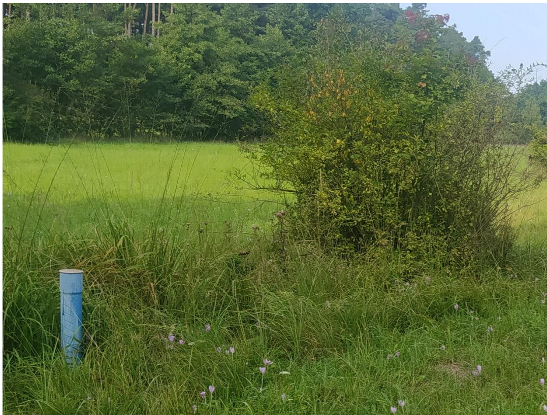
Foto 7 Sonda na měření hladiny podzemní vody na DP 13, p. p. č. 291/1 (Prausová R., 2023)
