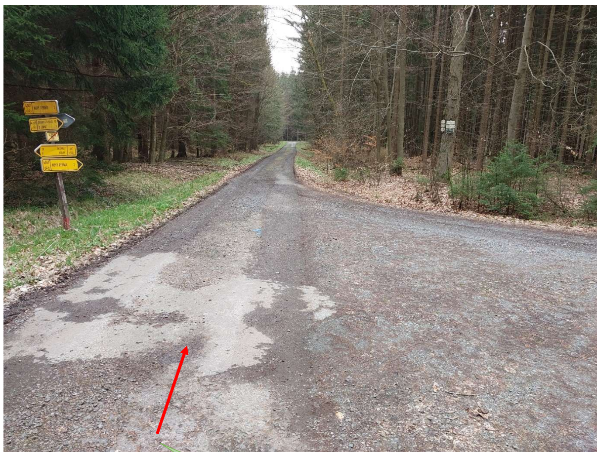
Obr. č. 4 z 20.4. 2023 – konec úseku
