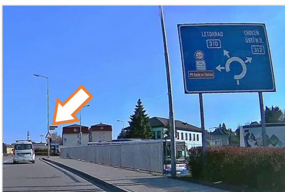
159/ Nadbytečně umístěná značka A 4 (viz šipka) těsně před okružní křižovatkou (II/310: Žamberk, Divišova)
