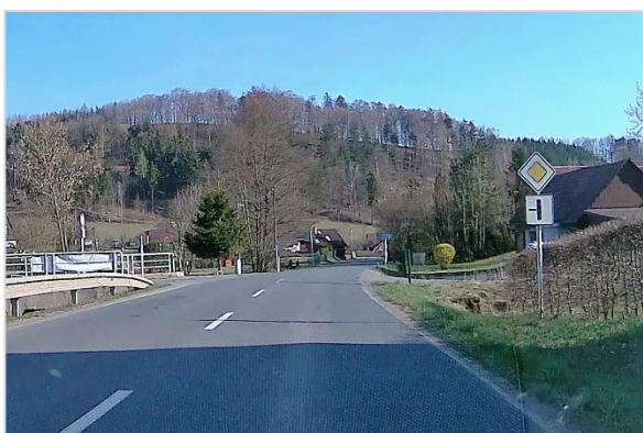
157/ Dodatková tabulka vyznačující obvyklý tvar křižovatky (II/312 x III/31014: České Libchavy)
