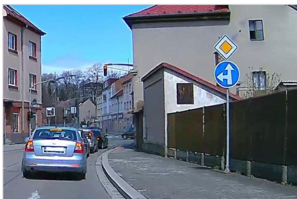
135/ Neobvyklé a příliš vzdálené umístění značky P2 mimo sloup semaforu (I/14: Česká Třebová, Riegrova)
