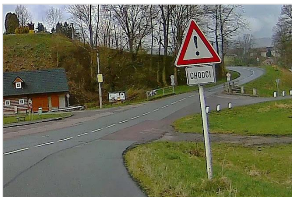
162/ Použití značky jiné nebezpečí s textovým dodatkem upozorňujícím na chodce (II/360: Řetůvka)
