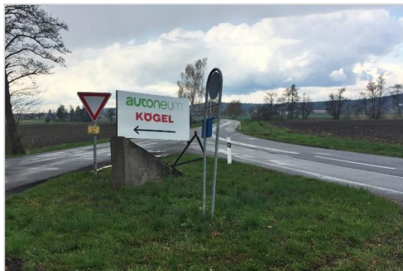
122/ Poutač brání v rozhledu před křižovatkou (II/315: Sruby – Choceň)
