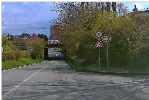
138/ Nesprávné pořadí, kombinace a umístění značek (II/358: Česká Třebová, Litomyšlská 107)
