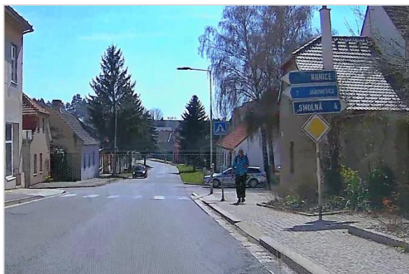
139/ Nepřípustná kombinace značky P2 s orientačním dopravním značením; spodní hrana navíc nesplňuje požadavek výšky 2,2 metru nad chodníkem (II/372: Jevíčko)
