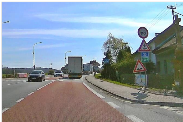
137/ Nesprávné pořadí značek a nadbytečné upozornění na přechod v těsné blízkosti (I/35: Jaroslav)
