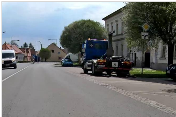
133/ Předčasně umístěná značka P2 je 45 metrů od hranice křižovatky (II/322: Dašice)
