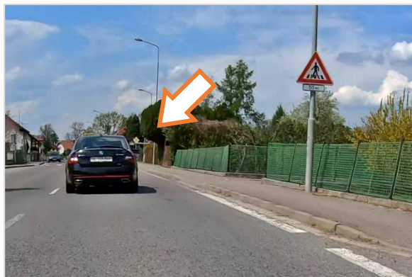
128/ Značka přechodu pro chodce (v místě šipky) zakrytá stromem (II/322: Dolní Roveň)
