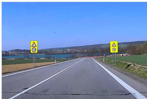
130/ Nepovolené užití zmenšených značek na silnici I. třídy, navíc nelogické vzhledem ke zvýraznění a rozdílnosti proti druhé straně (I/43: Opatovec – křižovatka s I/14)
