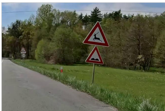
142/ Nepovolená kombinace značek různé velikosti (II/322: Dašice, Zminný – Pardubice)
