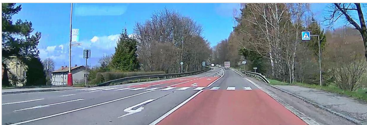
114/ Výrazně překročená maximální délka přechodu kvůli nadměrně dlouhému odbočovacímu pruhu (I/14: Dlouhá Třebová)
