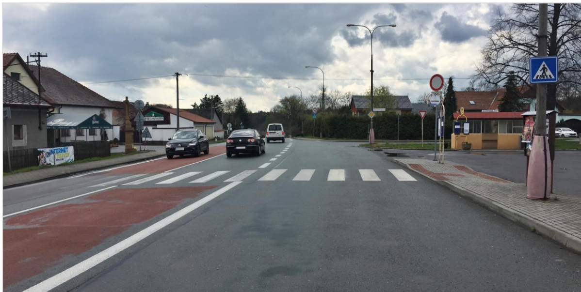
113/ Nevýhovující délka přechodu, který navíc vede doprostřed autobusové zastávky (I/35: Jaroslav)
