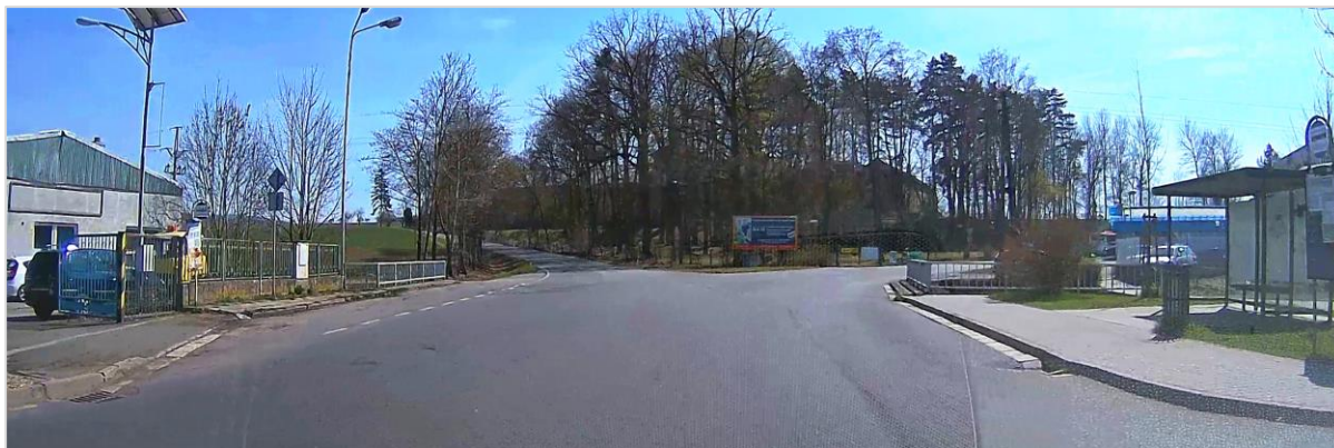
126/ Rozlehlost prostoru a absence vodorovného značení na křižovatce (II/372 x II/374: Jevíčko)
