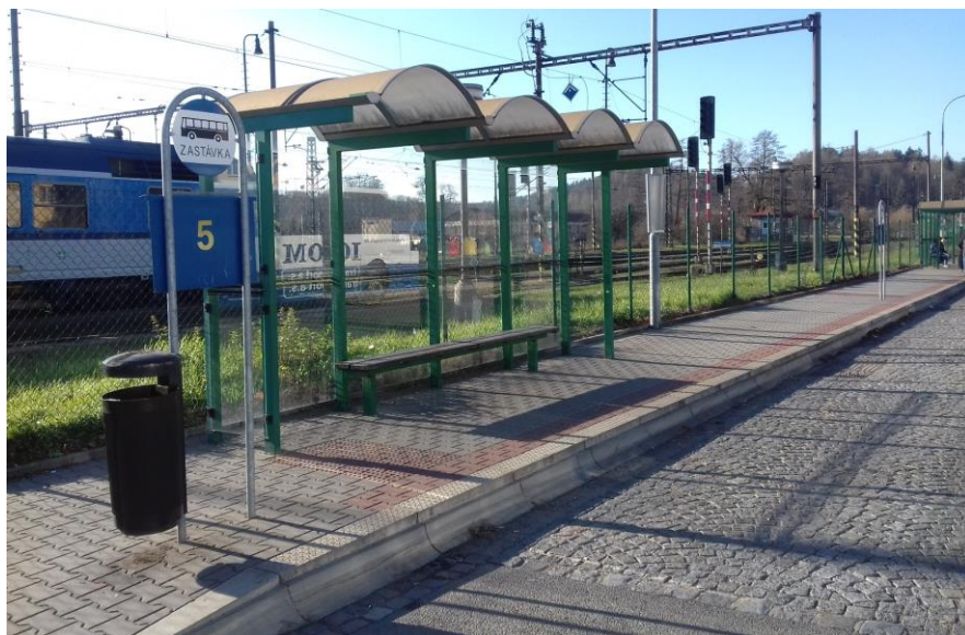
Obr. 1: Zastávka s bezbariérovým obrubníkem, přístupná z plochy chodníku. Zdroj: V. Vorel (2018)
