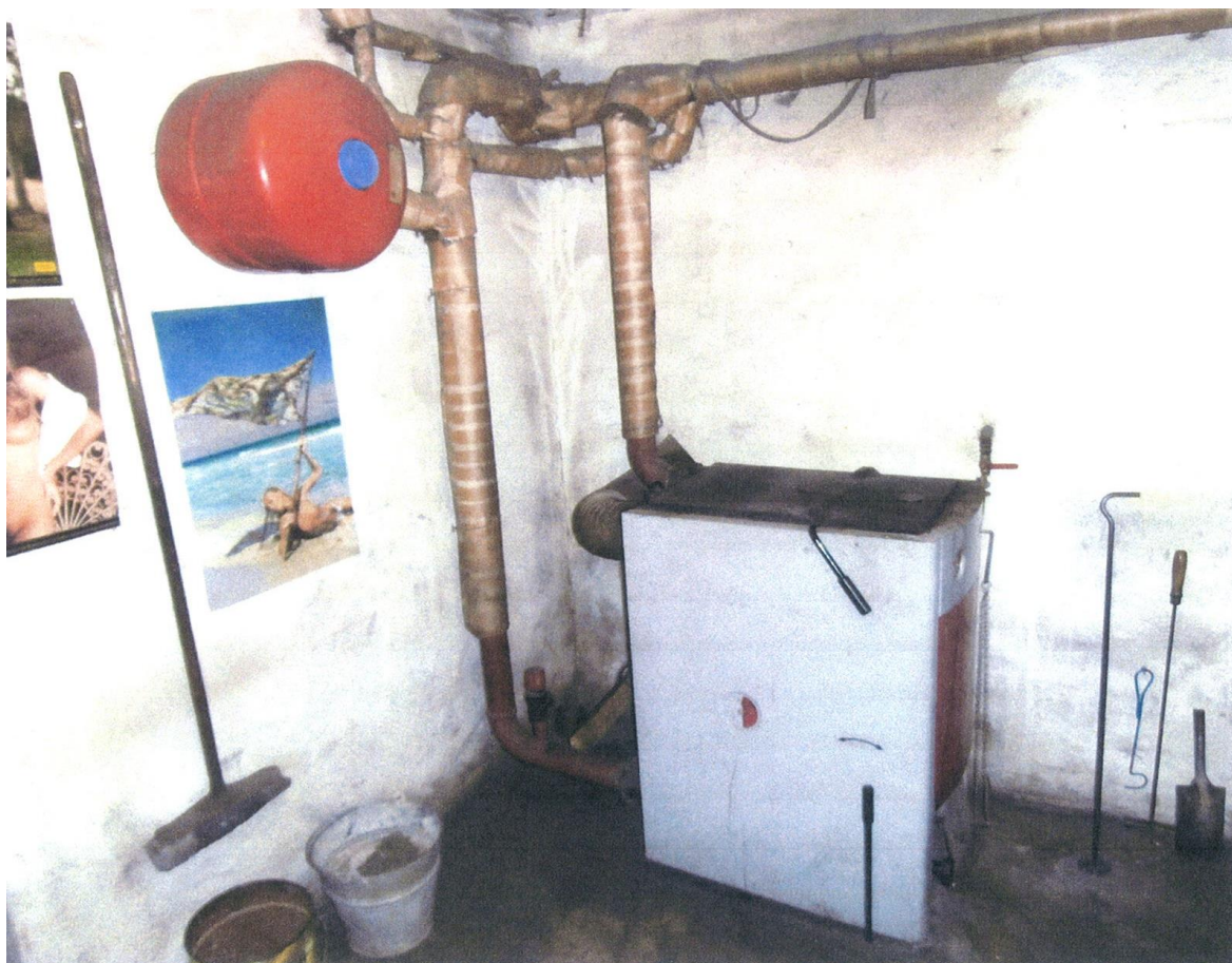
Foto č. 2 – Boční pohled na kotel se záběrem prostoru kotelny (napojení na otopnou soustavu)
