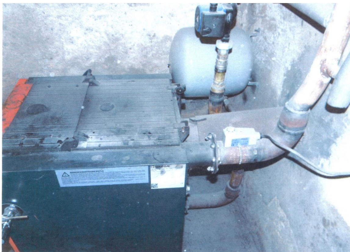
Foto č. 3 – Připojení kotle na otopnou soustavu – boční pohled
