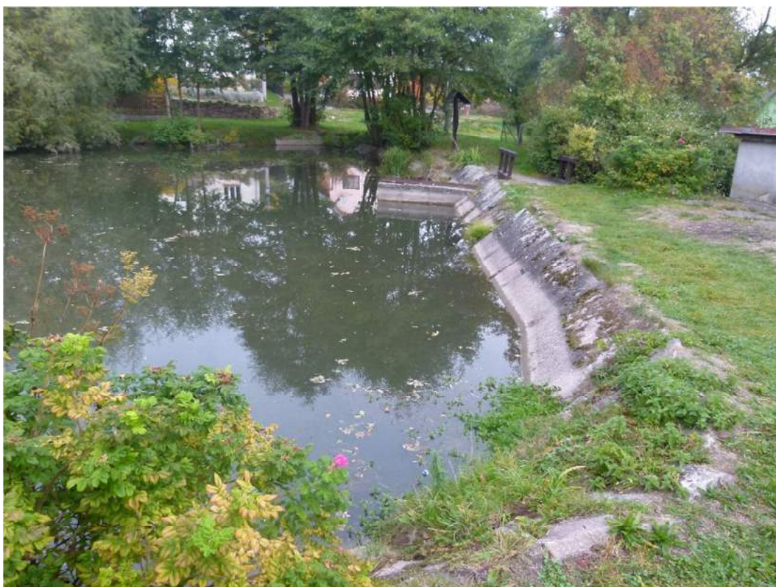
Pohled na hráz z pravé strany
