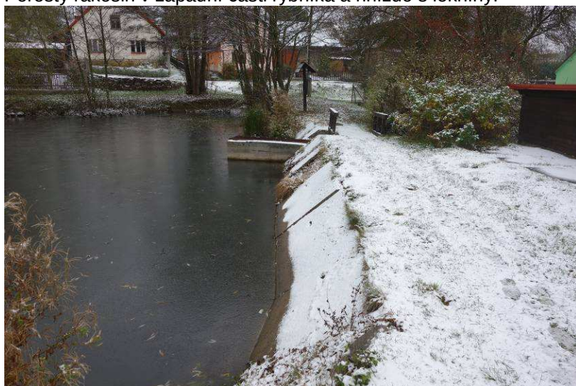
Pohled na betonovou hráz rybníka ve výhodní části.
