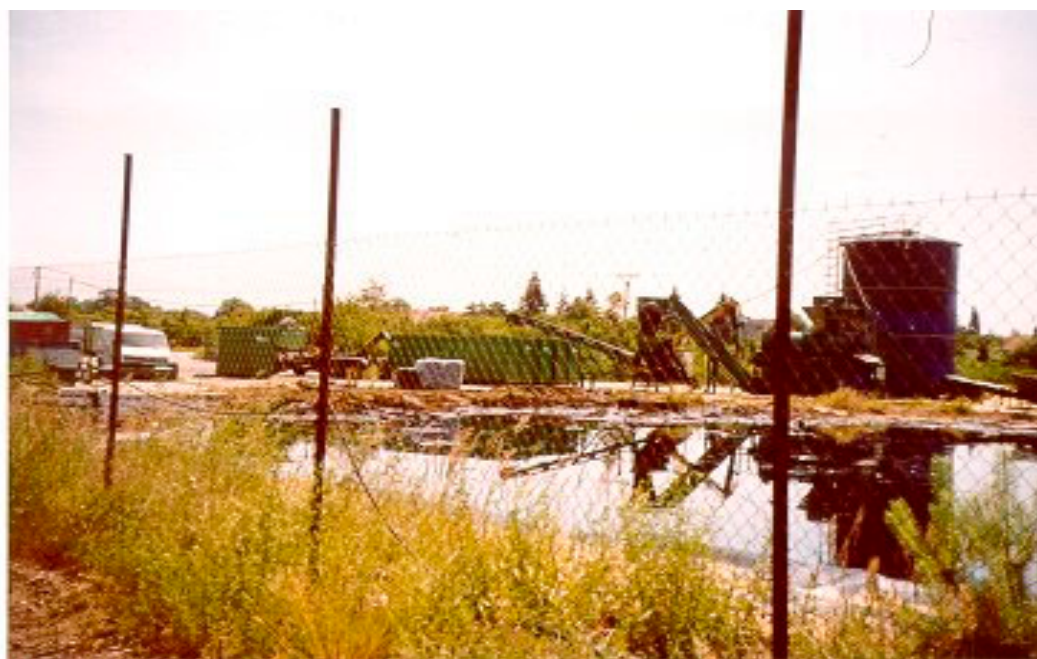
Obr. 8: Opuštěná část hlinišť na ložisku cihlářských surovin Časy. Likvidace sanace deponie ropných derivátů bývalého n.p. Paramo Pardubice. Řada opuštěných těžeben v kraji se stala prostorem pro skládkování. (stav v r. 2003)
