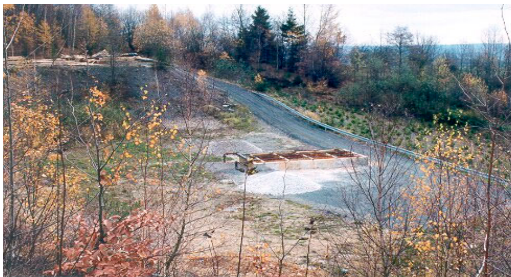
Obr 7: Prostor bývalého závodu Rudných dolů před ústím těžební štoly se zařízením na neutralizaci důlních vod na ložisku Ba-F Běstvína ( stav v. r. 2002)
